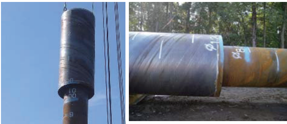
写真1 拡頭タイプ (φ800 mm+φ1 200 mm) の例 Photo 1 Enlarged pile head ( D_p : 800 mm+1 200 mm)
