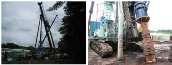
写真4 斜杭施工試験実施状況
