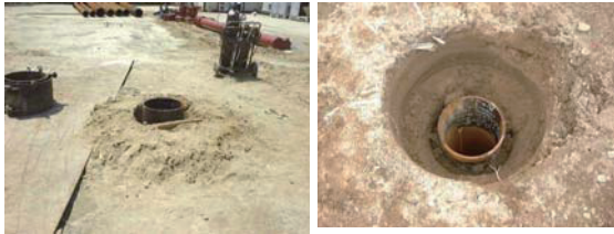
写真3 施工完了後の地表面
